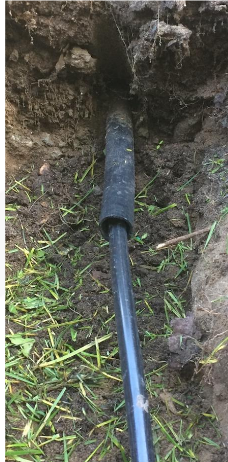
Bestandsrohr am Grundstück
